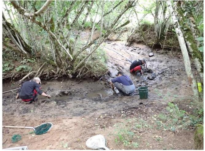
Mise en assec d'une mouille par pompage le 28/08/2023 (avant / après) sur le cours aval du ru d'Inières
